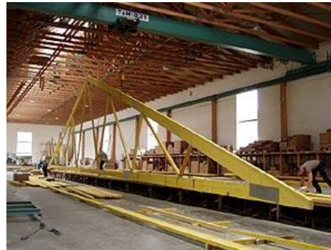
Fertigteile einer Nagelplattenkonstruktion
